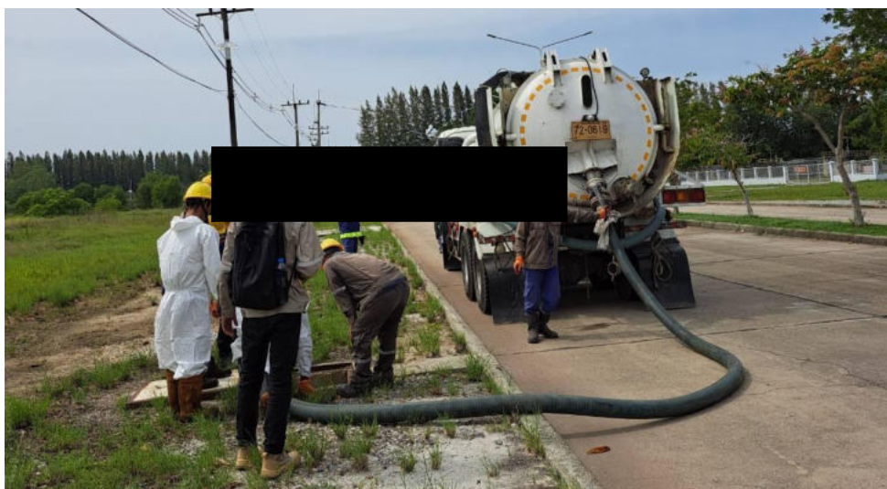
ภาพการทำงานลอกท่อระบายน้ำ ถนน F (ถนนขนานพื้นที่โครงการ Mar)
